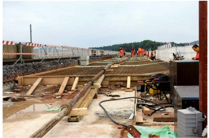
**Bild 11** Betonpumpleitung mit bis zu 300 m Länge
