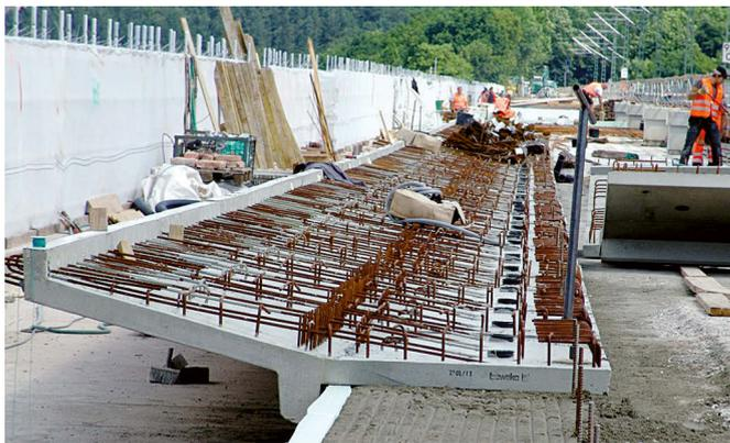
**Bild 8** Kragarmfertigteile mit externen Zugbändern
