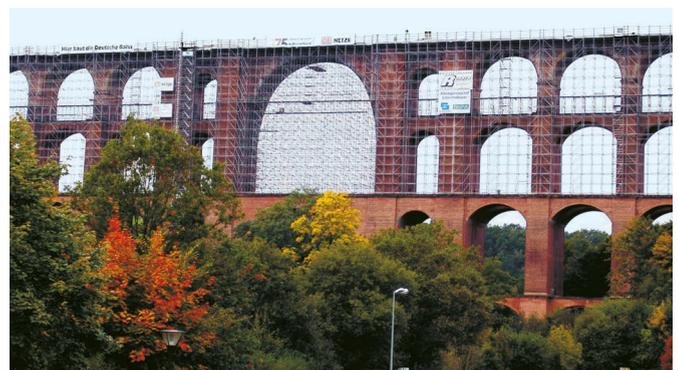
**Bild 9** Das Gerüst für den ersten Bauabschnitt
