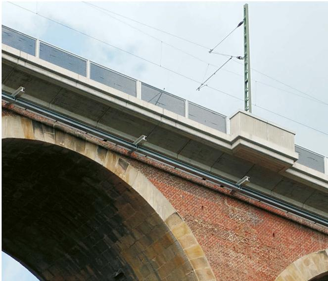
**Bild 6** Detaillösungen für Gesimse, Geländer und Brüstungen
