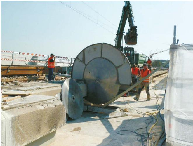
**Bild 10** Teilabbruch der vorhandenen Konstruktion mit Sägetechnik
