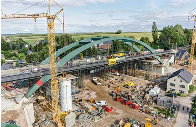
Bild 27. Brückenbauwerk nach dem Vershub in finaler Lage (© Deutsche Bahn)
