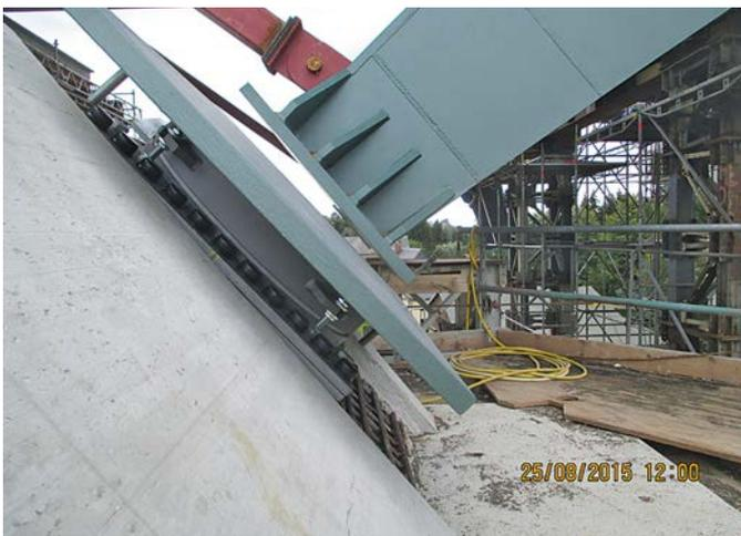
Bild 25. Lager und Bogenfußpunkt während des Verschubes
