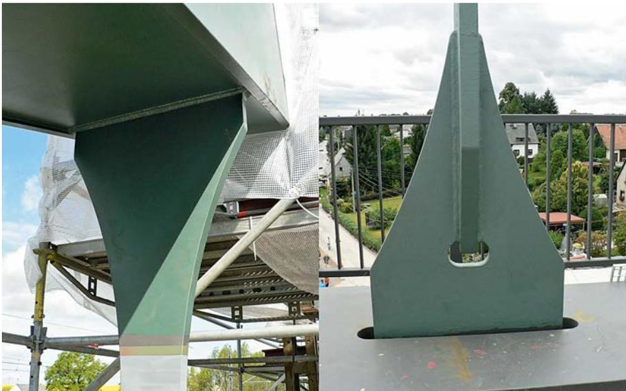
Bild 8. links: oberer Hängeranschluss, rechts: unterer Hängeranschluss
