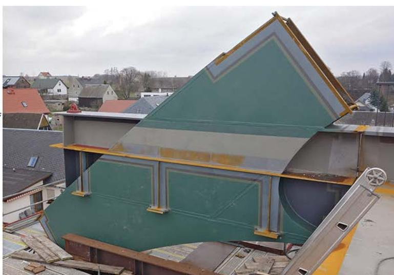
Bild 7. Durchdringungspunkt zwischen Bogen und Versteifungsträger
