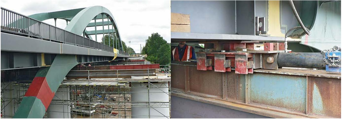
Bild 24. Brückenverschub, links: Blick auf die Hauptverschubbahnen, rechts: Verschubschlitten und Presse
