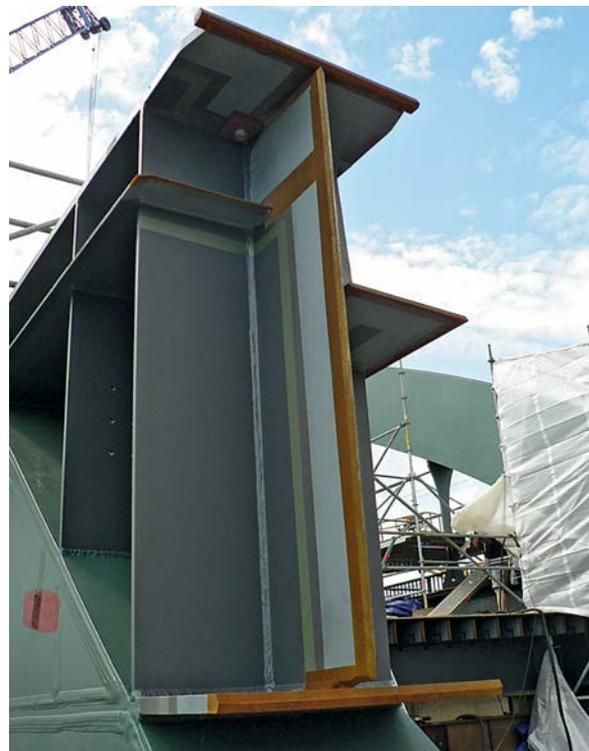
Bild 6. Versteifungsträger
