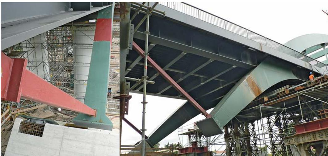
Bild 26. Temporäre Montagestreben für den Verschubzustand
