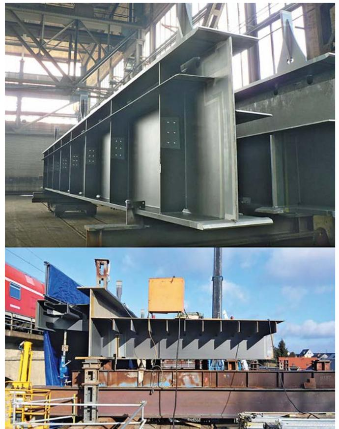
Bild 16. Vorfertigung und Zusammenbau der Versteifungsträger- und Fahrbahnsegmente (unten © Deutsche Bahn)
