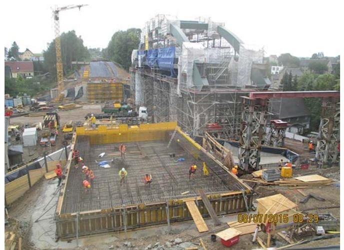
*Bild 23. Herstellung der neuen Widerlager*
