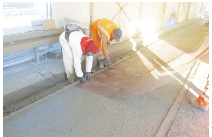
Bild 10 Herstellung eines Längsstreifens an Teilbauwerk 2 und Einlegen der Carbongelege Execution of a longitudinal stripes on superstructure no. 1 and implementation of a carbon layer
