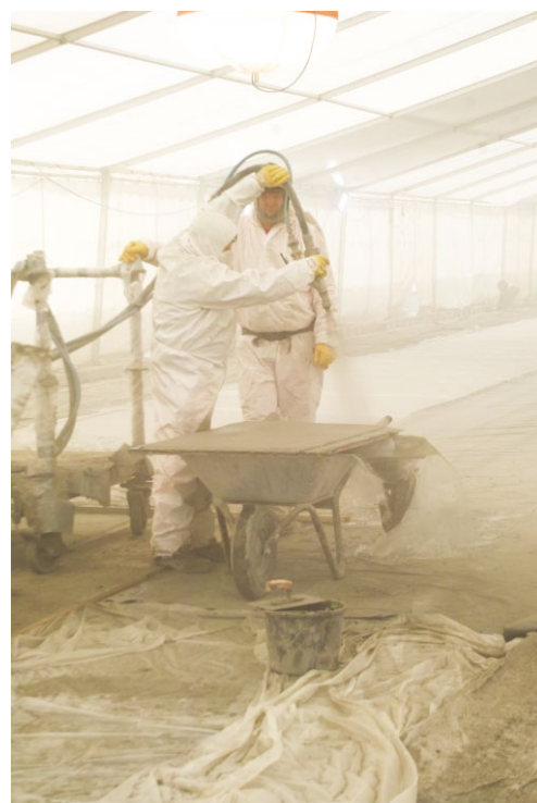
Bild 7 Herstellung einer Platte für Prüfkörper im Rahmen der Qualitätssicherung Production of a testing plate for a quality check on construction site
