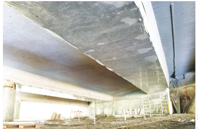
Bild 9 Erfolgreich verstärkte Untergurte der Stege am Teilbauwerk 2 – Nachbehandlungsphase Strengthened webs at the bottom of the superstructure – superstructure no. 2 – post treatment
