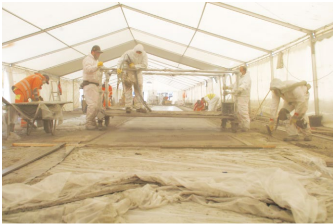
Bild 8 Herstellung eines Längsstreifens an Teilbauwerk 1 und Ausführung des mittigen Arbeitsstoßes Execution of a longitudinal stripe at superstructure no. 1 and construction joint in the middle
