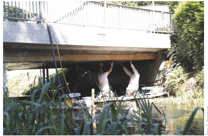
Bild 7 Verstärkungsarbeiten an der Plattenbrücke in Kleinsaubernitz/Sachsen Strengthening of a concrete bridge in Kleinsaubernitz/Saxony
